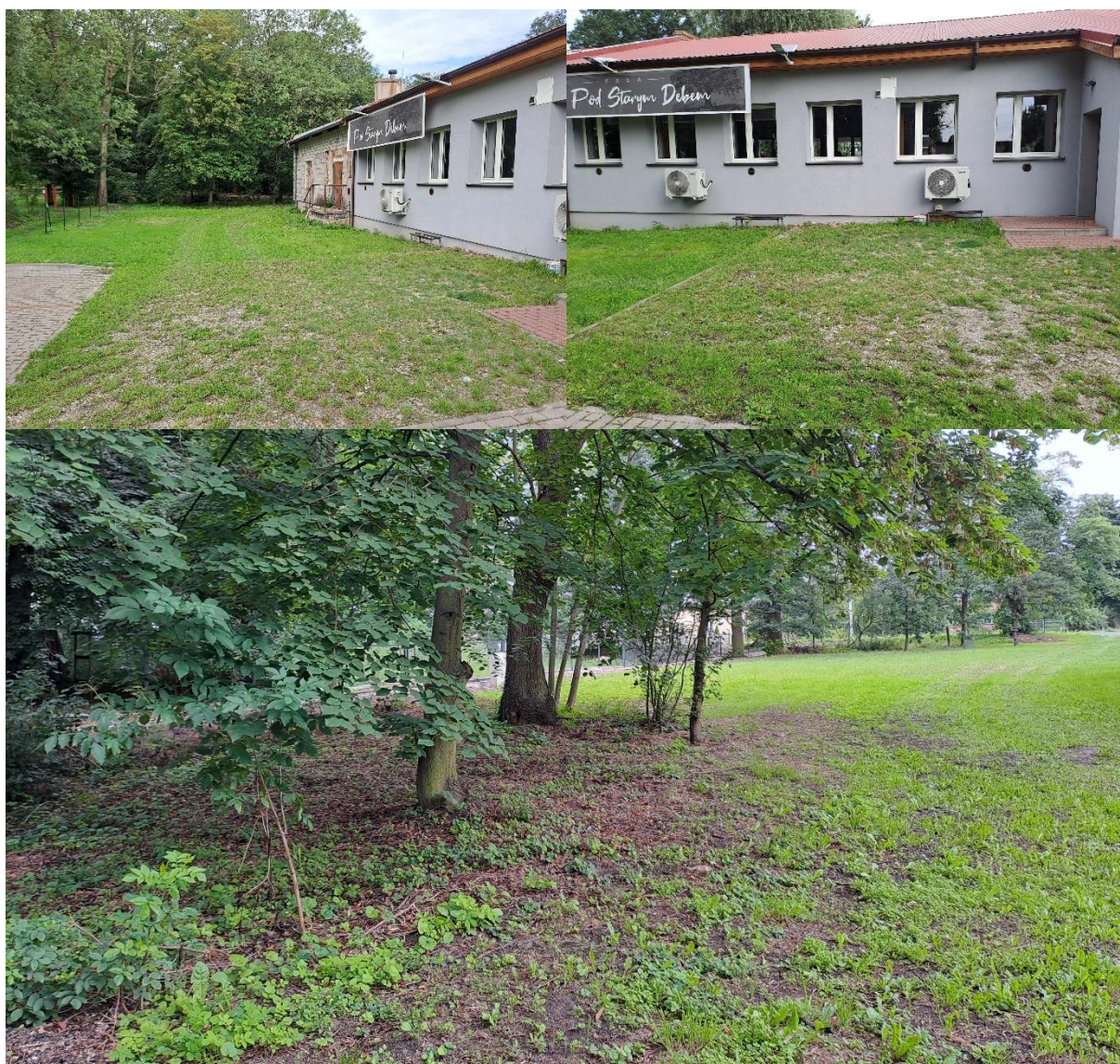
Źródło: Wizja lokalna przeprowadzona w dniu 31 lipca 2025 r.
